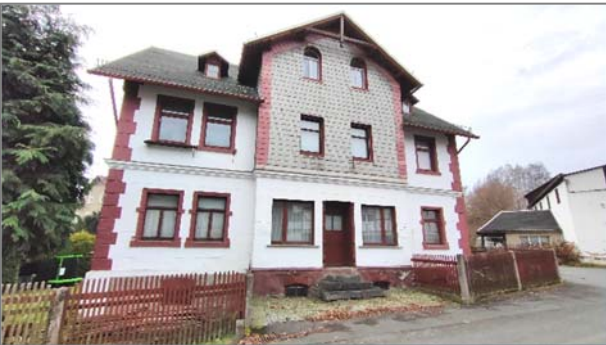
Die ehemalige Bäckerei, heute reines Wohngebäude.
