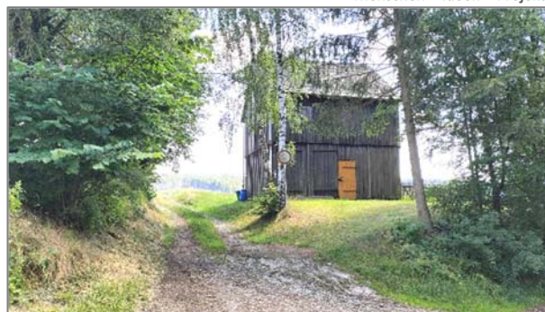
Feldscheune am südlichen Ortsrand von Venzka.
