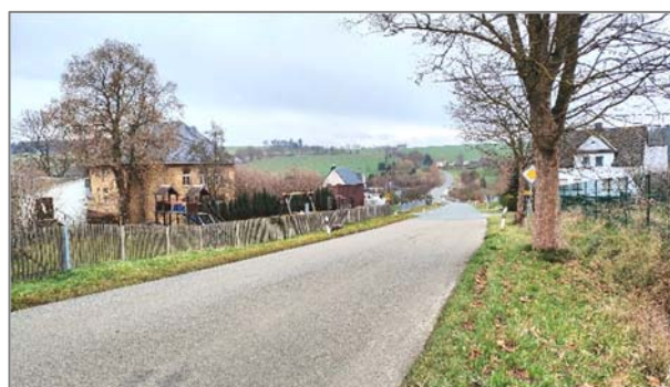
Die Straße von Frössen nach Ullersreuth am südlichen Ortsrand von Göritz. Geradlinigkeit und wenige Anbauten verleiten zu überhöhter Geschwindigkeit. Die Einordnung von Verkehrsteilern wird angestrebt.
