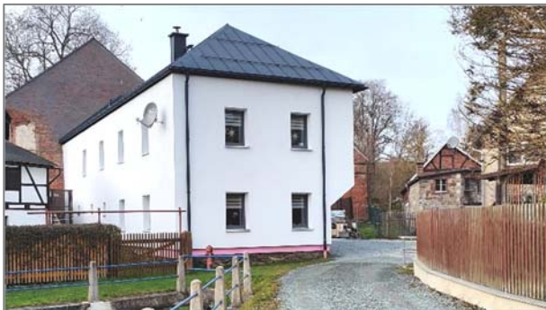
Saniertes Wohngebäude eines Hofes in Ullersreuth. Der Rhythmus von Öffnungen und Fläche wurde bewahrt. Jedoch geben großflächiges Dacheindeckungsmaterial und fehlende Fassadengliederung ohne Faschen und Bänderung sowie weiße Fassade eher ein nüchternes und sachliches Erscheinungsbild.
