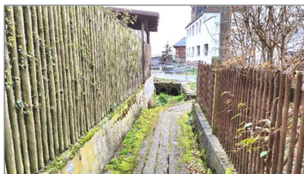
Die Schlippe oberhalb des Teiches. Der Lohbach fließt hier zwischen der angrenzenden Bebauung, überbaut mit einem Steg.
