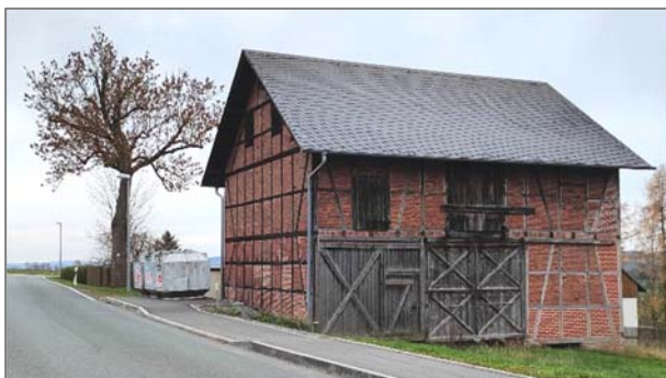
Typische Feldscheunen in Lehesten (oben) und Ullersreuth (unten). Wer es sich leisten konnte, hat das Fachwerk ausmauern lassen. Ältere bzw. einfachere Ausführungen in Brettverschalung.
