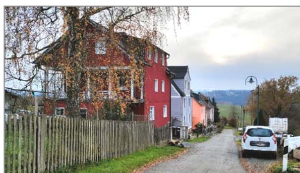
Ortserweiterung Richtung Südwesten mit Siedlungshäusern um 1900.
