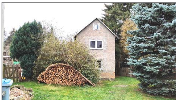
Nr. 40, das ehemalige Armenhaus des Dorfes.
