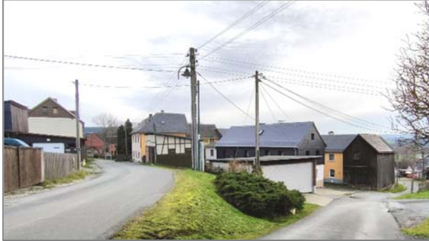
Nicht nur in Venzka stören die Freileitungen von Energieversorger und Telekommunikation das Ortsbild zum Teil erheblich.
