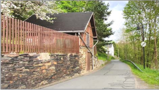
Sockelmauer aus Schiefer mit aufstehendem Holzlattenzaun in Sparnberg. Dazu passend der Keller mit darüberliegender kleiner Tenne.
