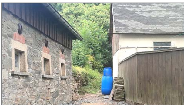
Abgehende Mauer am Grundstück des Dorfgemeinschaftshaus mit beginnendem Hohlweg.
