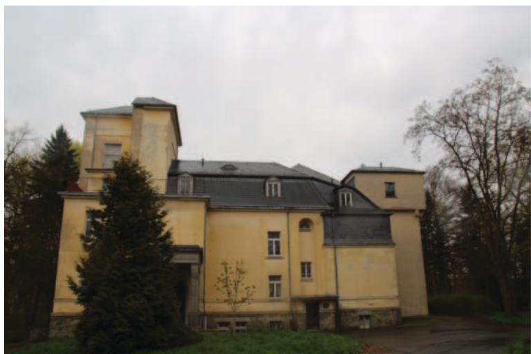
Abb. 22 Villa in der Parkanlage Friedrich-Fröbel-Straße
