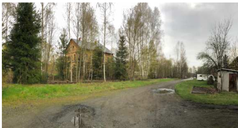
Abb. 50 Blick auf das ehemalige Bahnhofsgebäude
