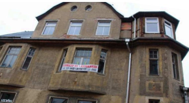
Abb. 53 Frei stehendes Gebäude
